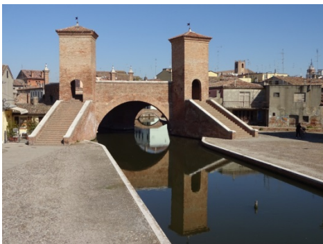
Brücke „Tre Ponti“ in Comacchio
